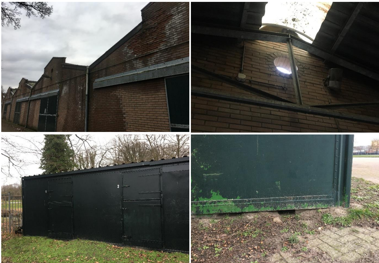
Afbeelding 7 - 10 Impressie van de stallen, met boven de bakstenen stallen met één van de grotere openingen voor vogels en vleermuizen en onder een aantal van de extra boxen met ruimte onder de box voor kleinere zoogdieren zoals steenmarter.
