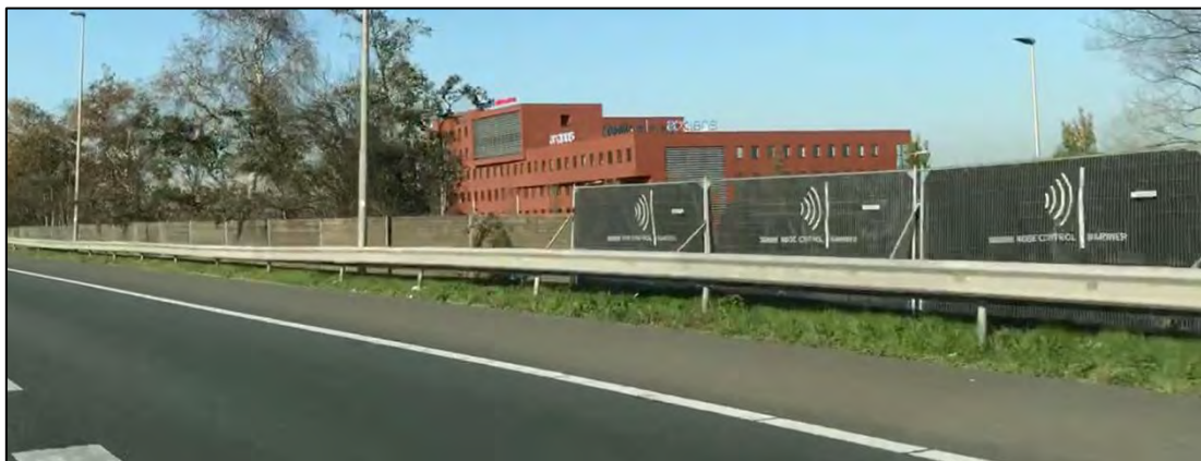
Figuur 3: Een nieuw scherm sluit aan op het bestaande houten scherm en vervangt de Sound Shields
