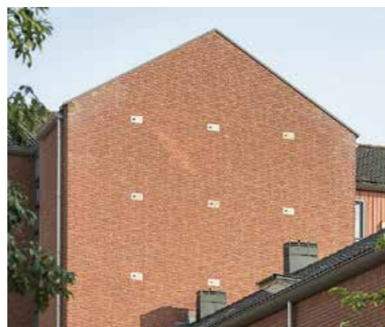
Nestkasten ingebouwd in de gevel
