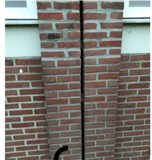
Deze dilatatievoeg, in een van de portieketage flats, is een belangrijke nestplaats voor meervleermuizen.
