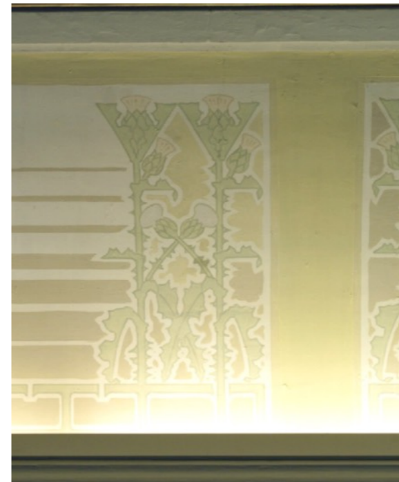
Restauratief retoucheren sjabloon schilderwerk plafonnd
