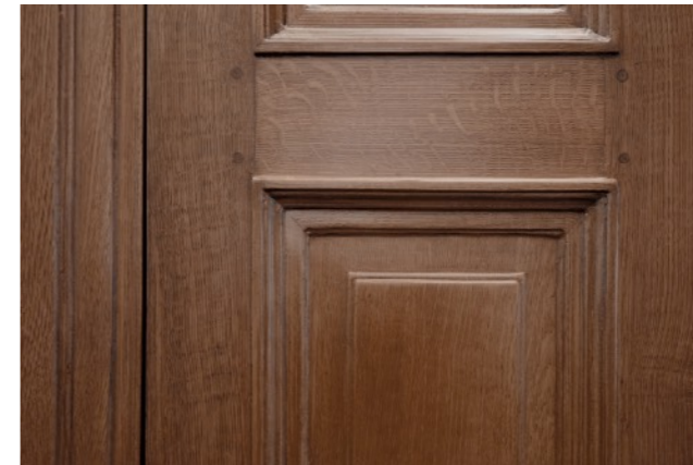
Deuren en deurkozijnen: imitatieschilderwerk eiken
