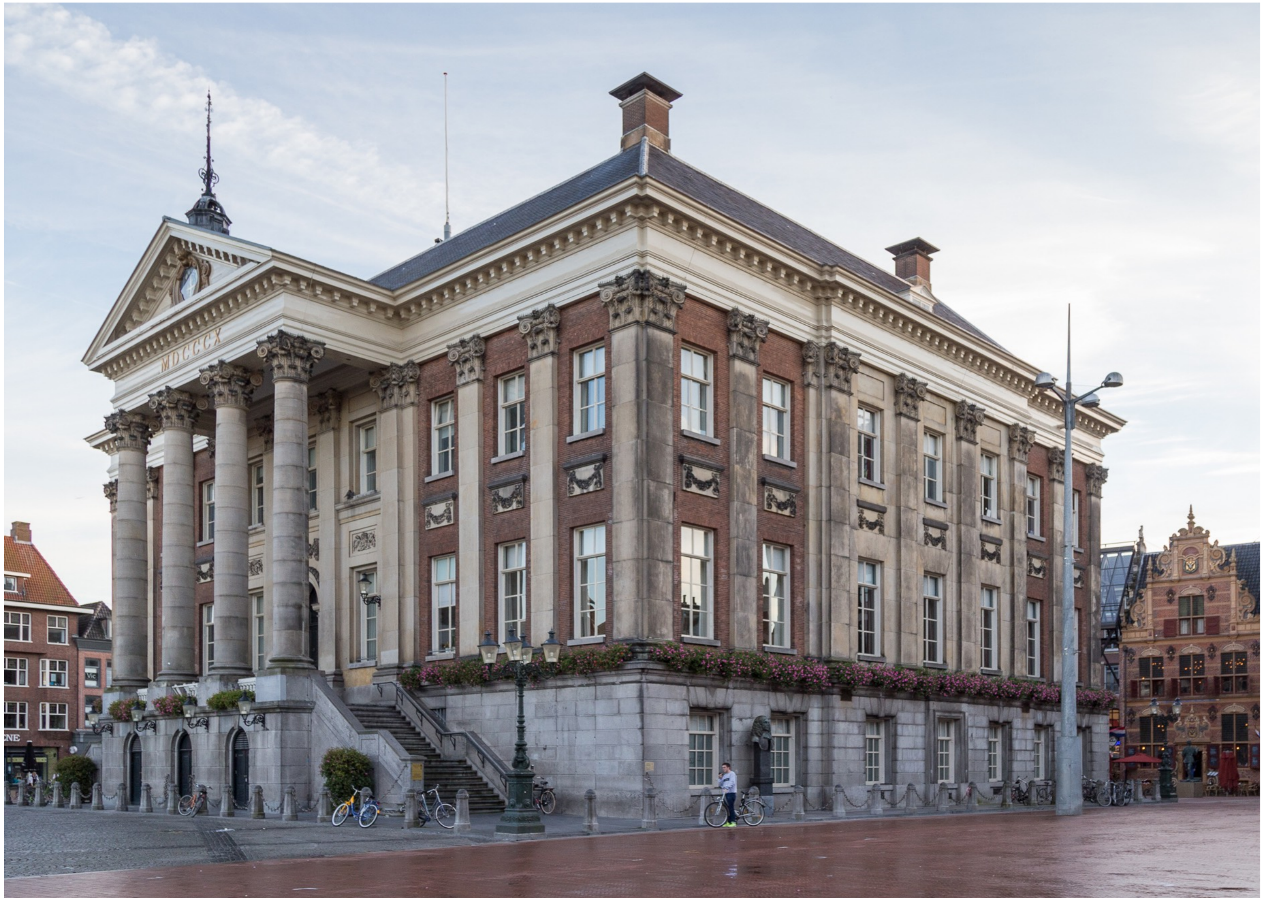
A. Restauratieve onderhoudswerkzaamheden aan de schil ten behoeve van de presentatie van het stadhuis in de stad.
