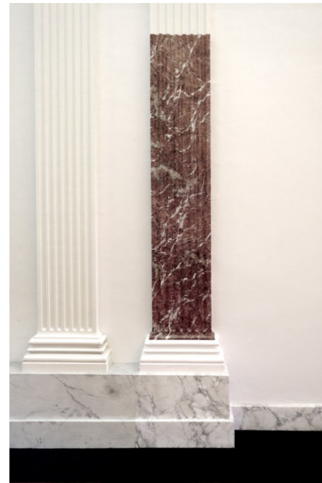
Pilasters, plint, basement, plafondlijst: imitatieschilderwerk marmer. Wanden sauzen in vuil/ kranten wit
