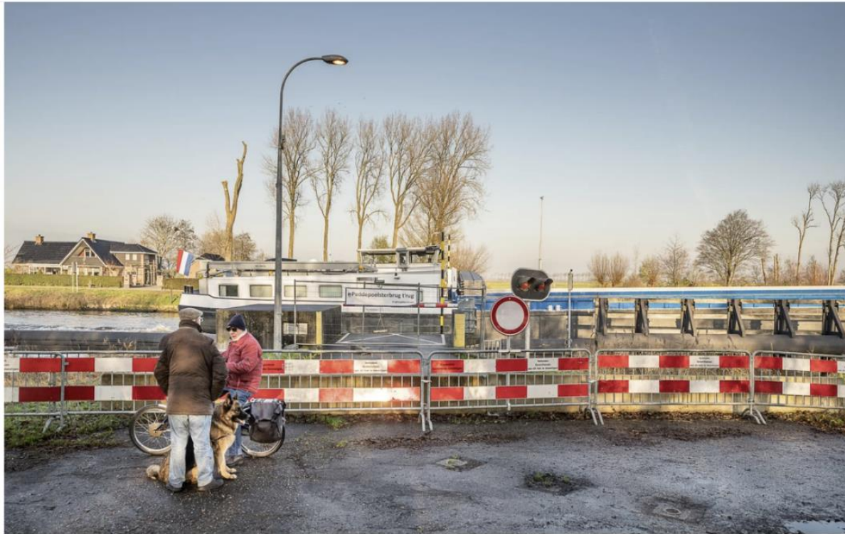
Hondenuitlaters bij de plek van de Paddepoelsterbrug. De in 2018 door een aanvaring beschadigde brug is nog steeds niet terug. Er kan geen fiets- of wandelverkeer meer oversteken. Beeld Harry Cock / de Volkskrant
