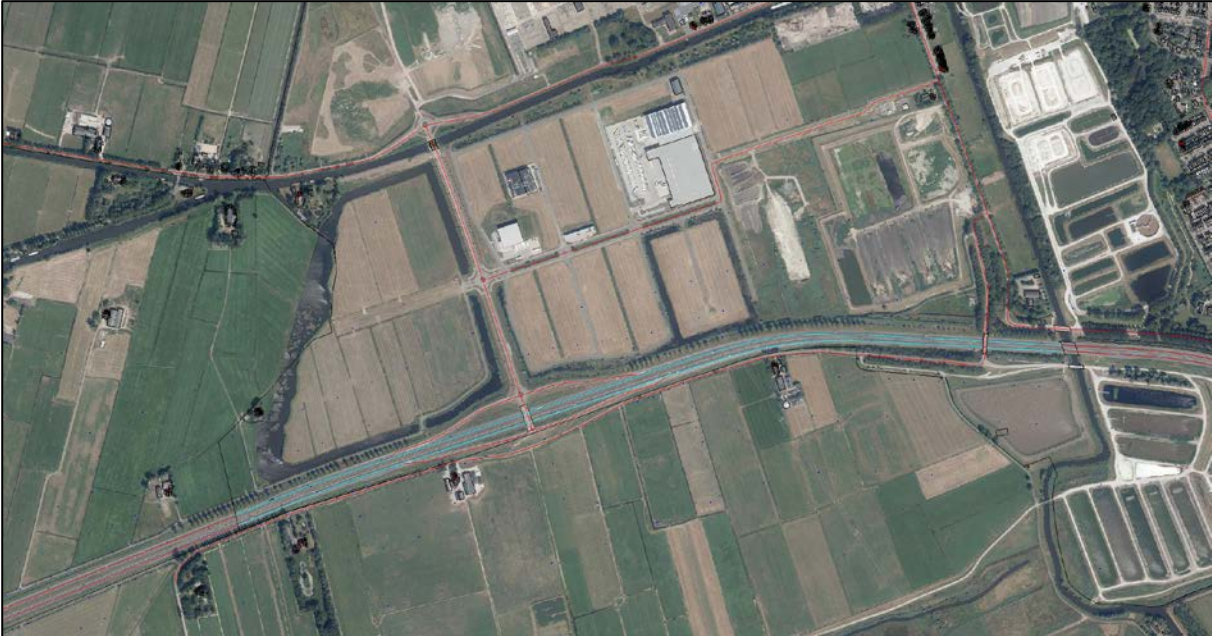
Figuur 12: Locatie geluidsreducerend asfalt (2 laags ZOAB)
