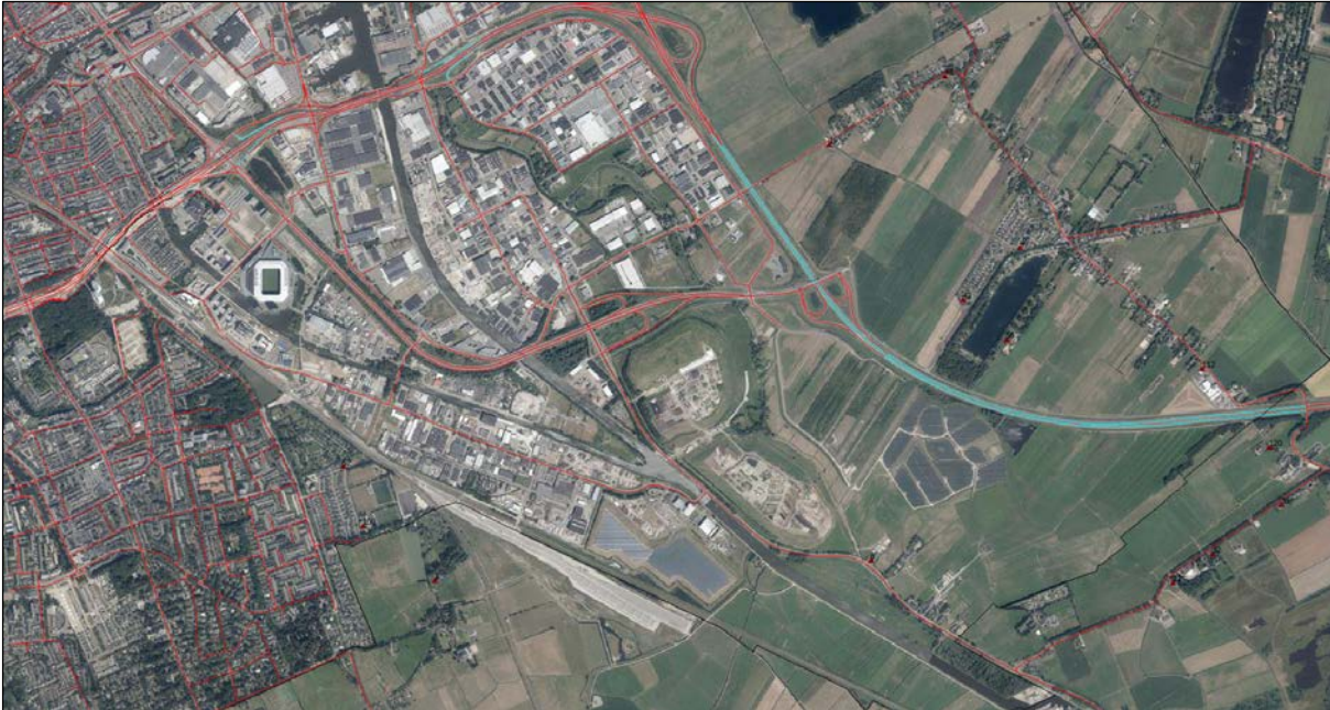
Figuur 26: Locatie geluidsreducerend asfalt (2 laags ZOAB)
