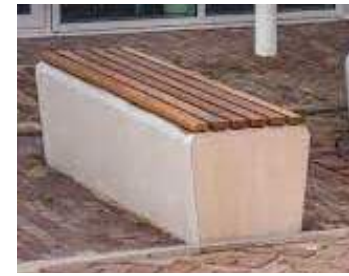
houten bekleding op beton
