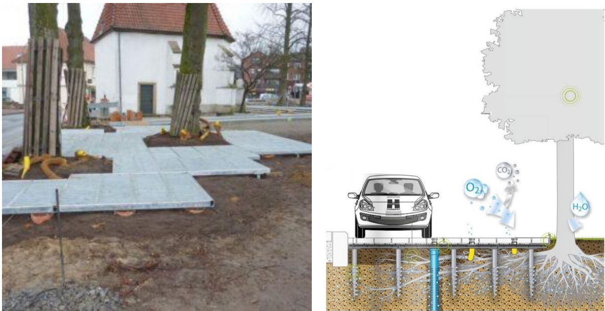
Afbeelding L en M: voorbeeld van een drukverdelend systeem uit verzinkt staal op poeren of schroefpalen (Humberg GmbH)
