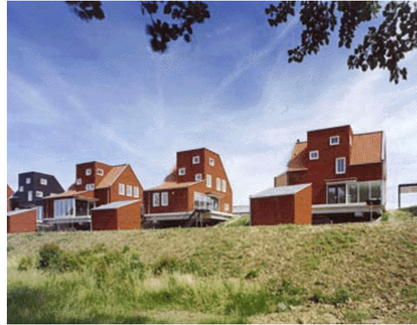
Een ensemble van woningen die zich op het kanaal richten (referentie: Papendrecht)
