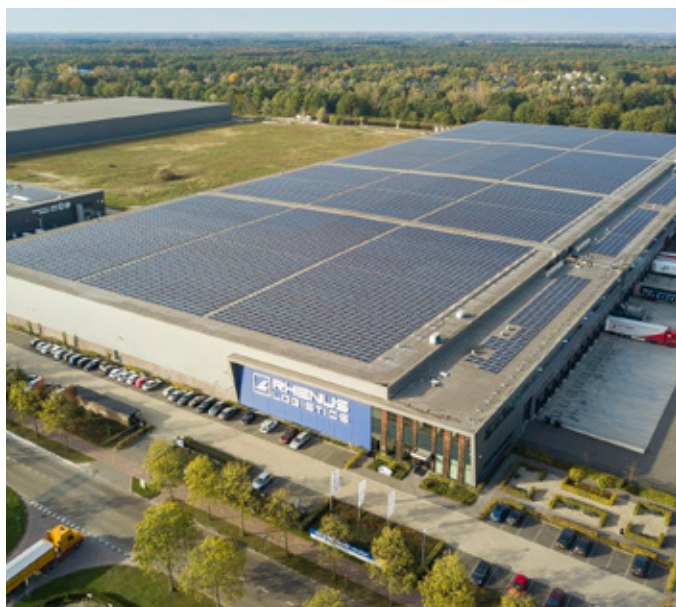
Zonnepark op platte daken, onder andere van bedrijventerreinen en winkelcentra (referentie distributiecentrum bij Eindhoven).
