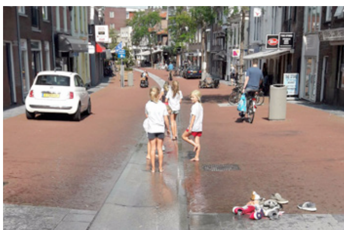
Bovengrondse waterafvoer. Referentie Woerden.
