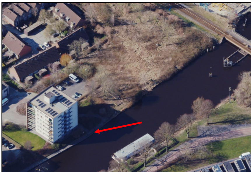
Figuur 4.13: huidige structuur waterkering aangegeven met de rode pijl
