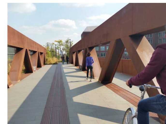
Paleisbrug, Den Bosch Foto door Nanda Sluijsmans
