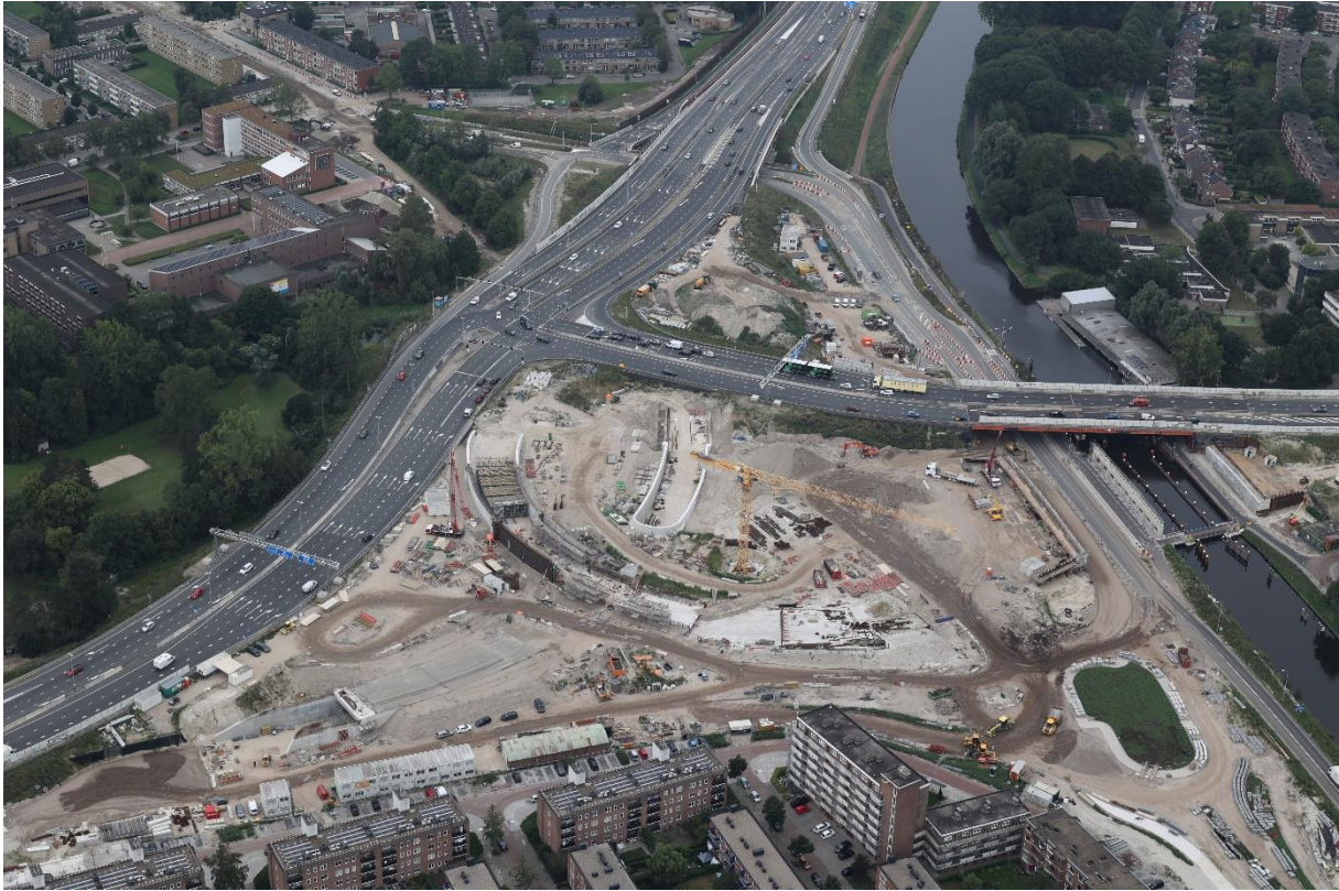
Vorderingen Julianaplein en Julianabrug
