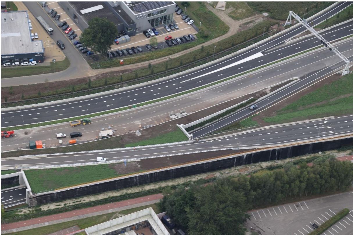
Oprit en afrit Bauhaus
