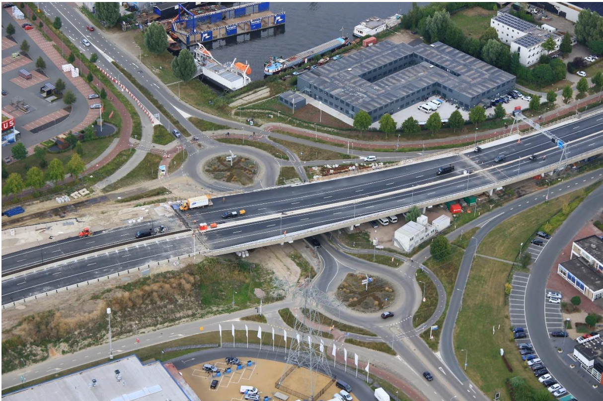
Ringweg ter hoogte van Bormholmstraat: duidelijk zichtbaar is het deel dat gereed en nieuw is.
