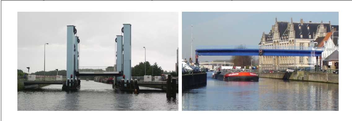
Afbeelding 4.2. Voorbeelden hefbrug (links) en tafelbrug (rechts)
