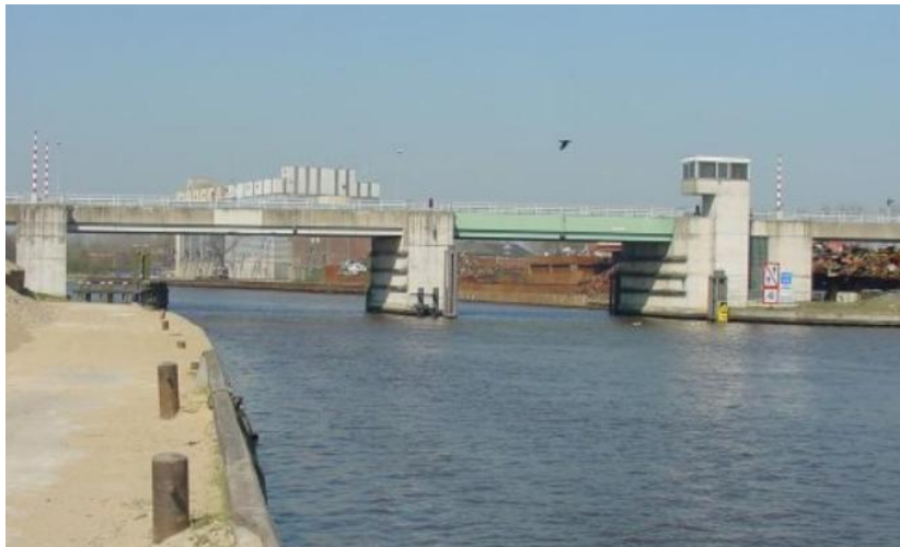
Afbeelding 2.3. Busbaanbrug (bron: Bruggenstichting)
