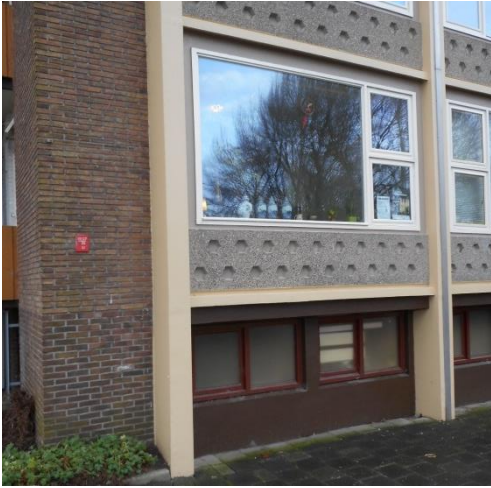
Spouwmuren vullen, borstwerping isoleren
