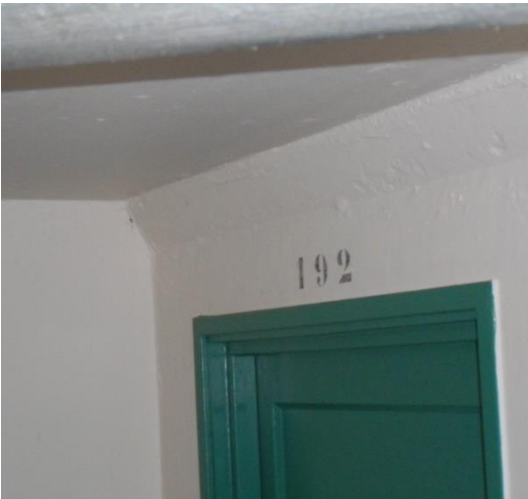
Plafonds in bergingen isoleren
