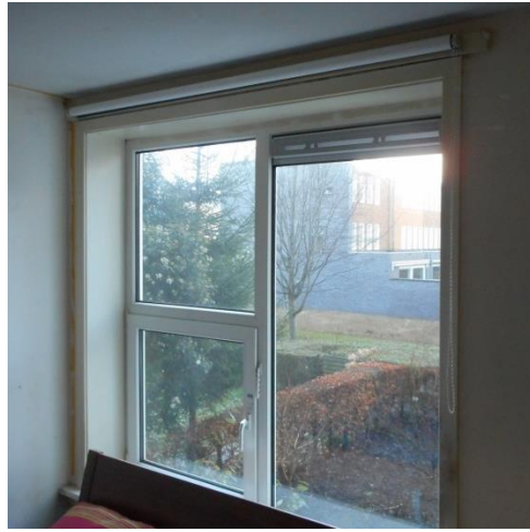
Overall dubbel glas en ventilatieroosters
