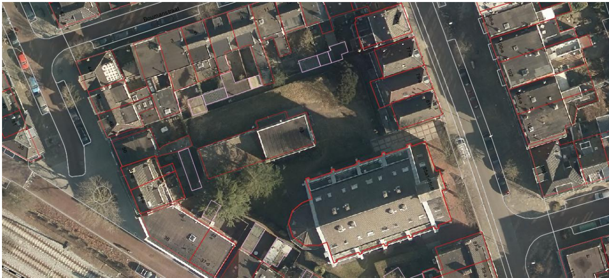
Luchtfoto van de huidige situatie op het binnenterrein
