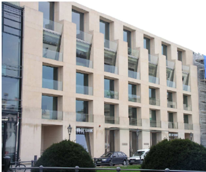
Contrasten in gevel en openingen
