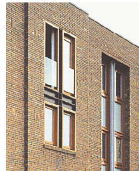
Baksteen gevel met gevarieerde openingen
