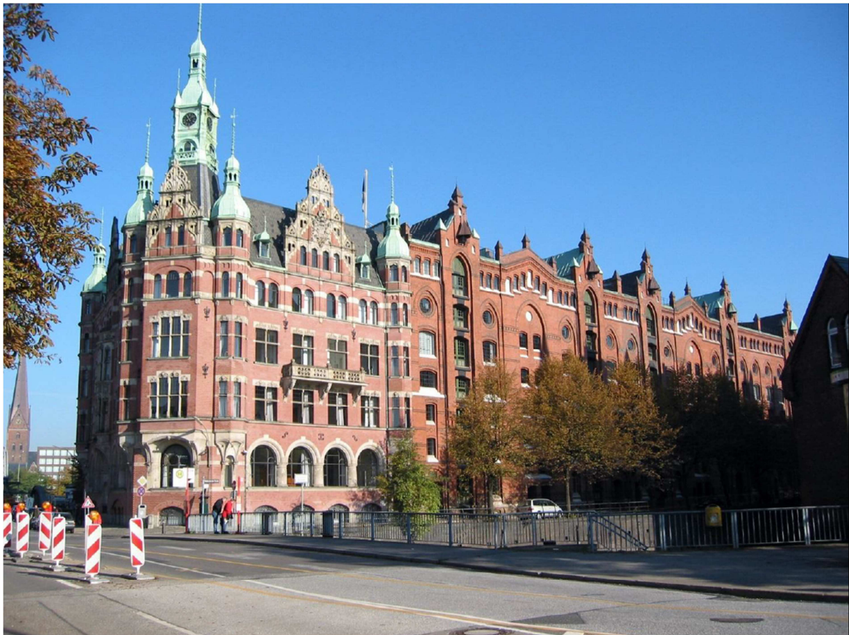
Speicherstadt Hamburg, Duitsland
