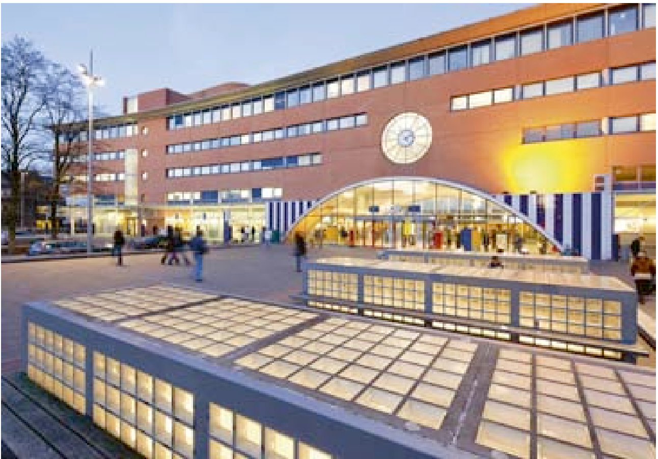
Het stationsplein met de bovenlichten van de perron- en fietstunnel, ter hoogte van de fietsenstalling
