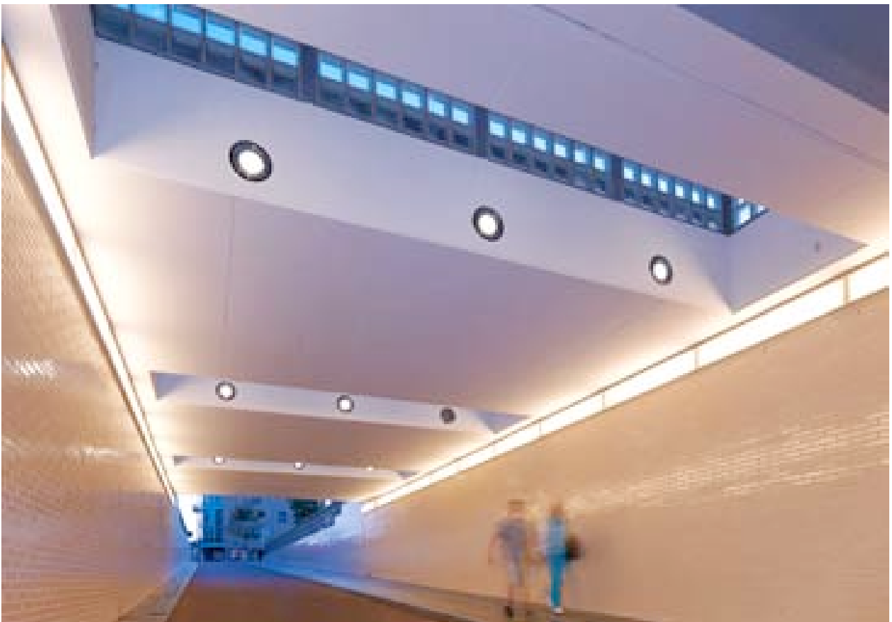
De bovenlichten vanuit de tunnel gezien
