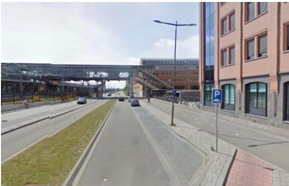
Zicht vanaf Parallelweg op passerelle
