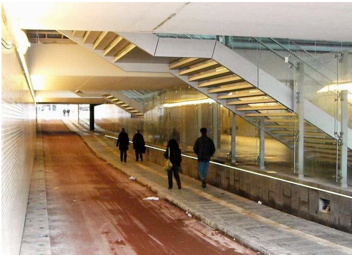
De fietstunnel, met rechts de perrontunnel en de trapopgangen naar de perrons
