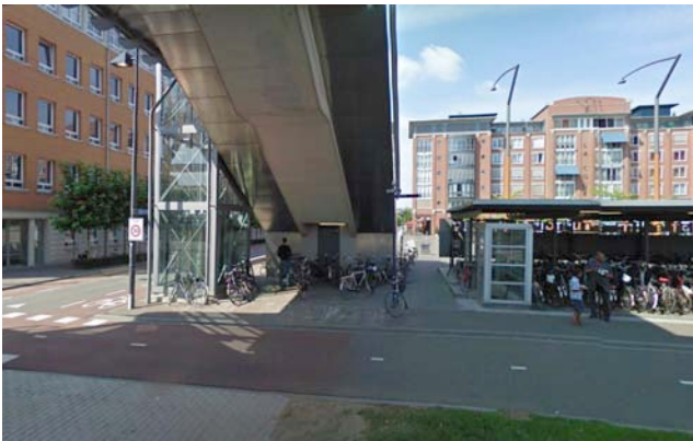
Zicht vanonder de passerelle
