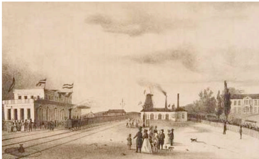
Eerste stationsgebouw Arnhem, 1845
