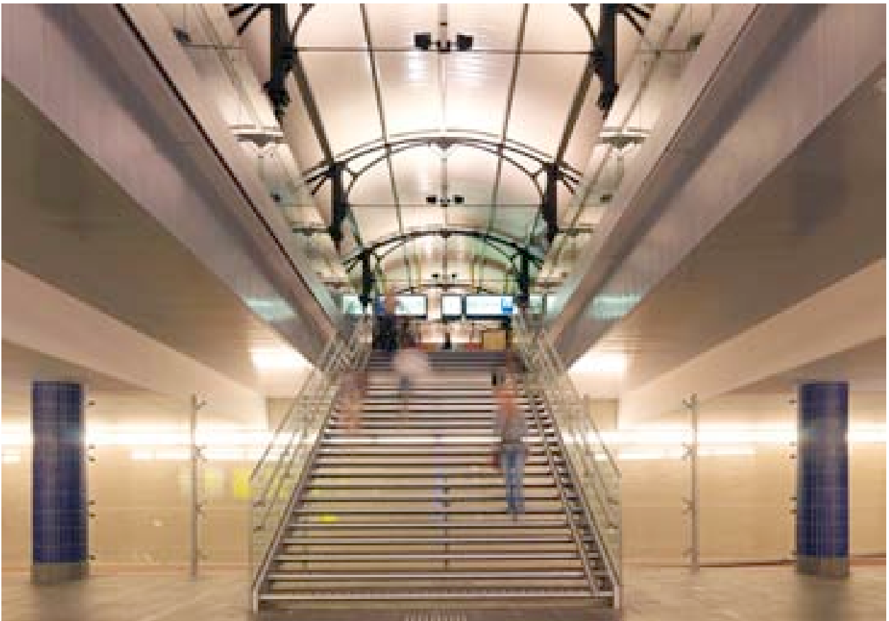
De trapopgang vanuit de perrontunnel, met daarachter de glazen wand als scheiding naar de fietstunnel
