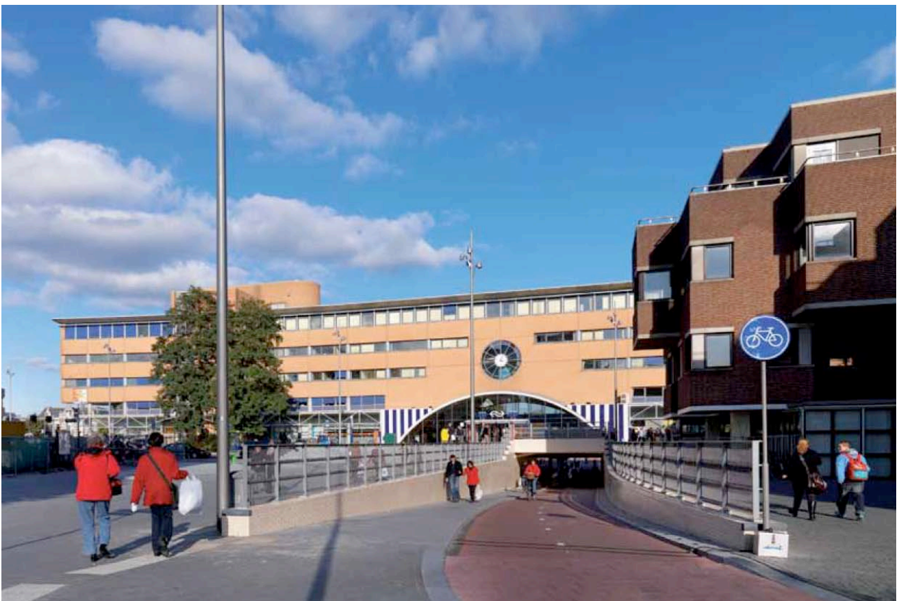
Het begin van de fietstunnel aan de zijde van de stad
