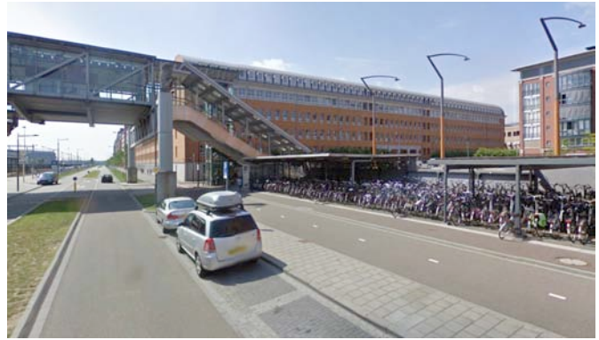
Zicht vanaf Magstratenlaan op passerelle, Paleis van Justitie en Leonardo Da Vinciplein
