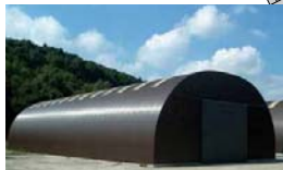
nieuwe opslagloods beheer sportpark
