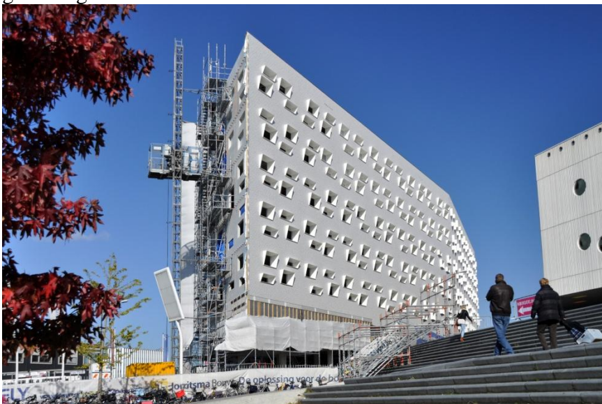
Afbeelding: Alfacollege in aanbouw
