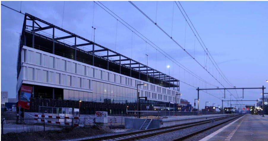
Afbeelding: Station Europapark en kantoorgebouw SoZaWe in aanbouw
