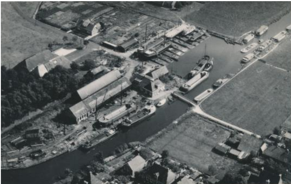
Overzichtsfoto van de voormalige scheepswerf met de scheepshelling van Barkmeijer ten oosten van het Koningsdiep/Vierverlaten, gezien richting het zuidoosten
