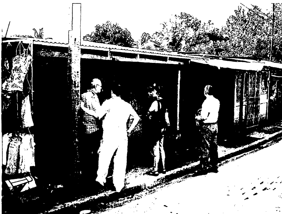
Woningverbetering in uitvoering
