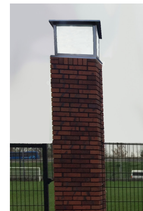
De kolommen van de toegangspoorten dienen te zijn uitgerust met een kubusvormig verlichtingsarmatuur met een omtrek gelijk of nagenoeg gelijk aan de omtrek van de kolom.
