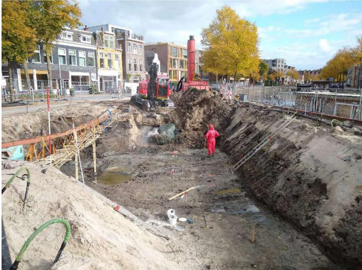
Figuur 6. Werkzaamheden tijdens de bodemsanering binnen het plangebied in 2020. Foto: J.W.D. Tuinstra.
