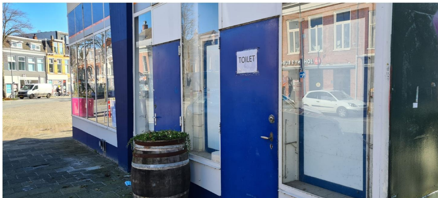
Toiletdeuren: Rechts oorspronkelijk hang-en sluitwerk, links niet.
