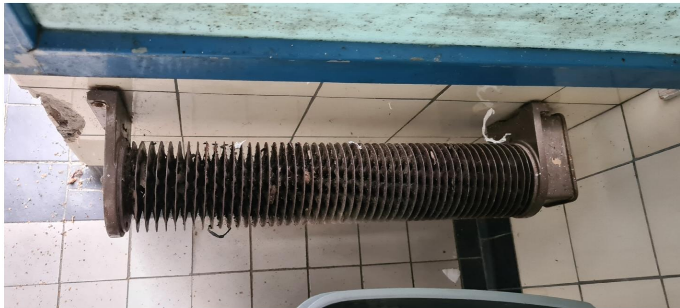
Oorspronkelijke buisradiator.
