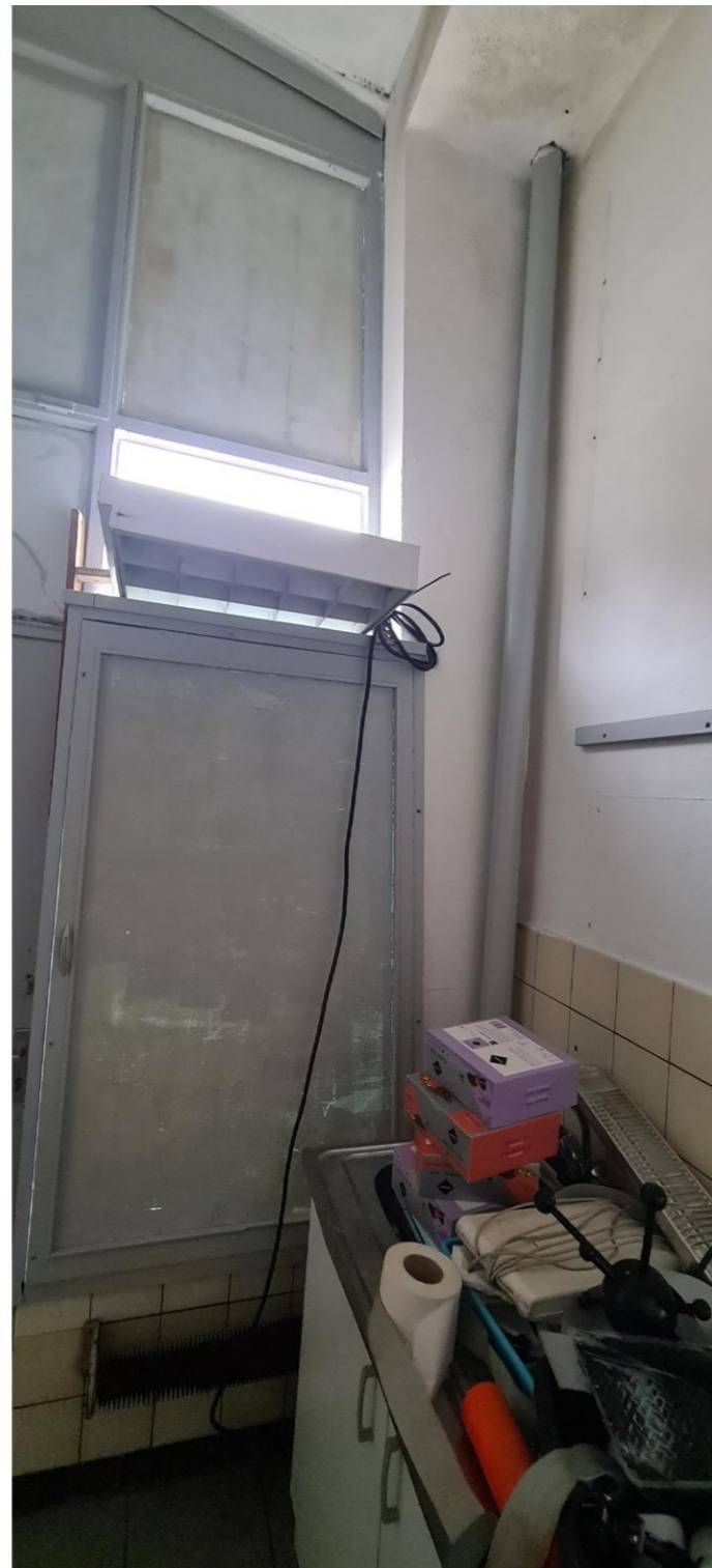
Ook in het toilet zijn nieuwe tegels over de bestaande tegels gelegd. Vitrine voorzien van gewalst glas. Bovenlichten dichtgeplakt. Inpandige HWA. Oorspronkelijke buisradiator.
