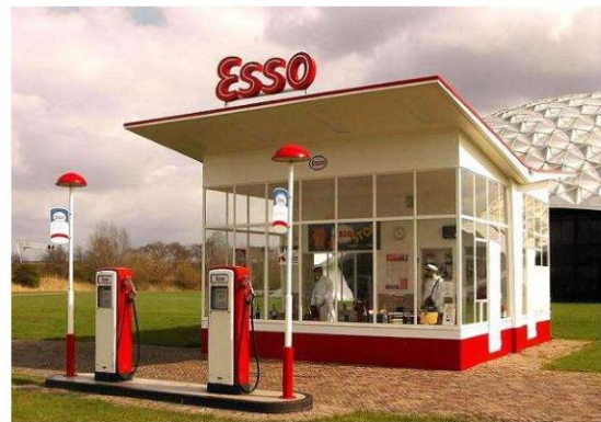
Oud tankstation van Vinkeveen na restauratie. Bron: Tankpro.
