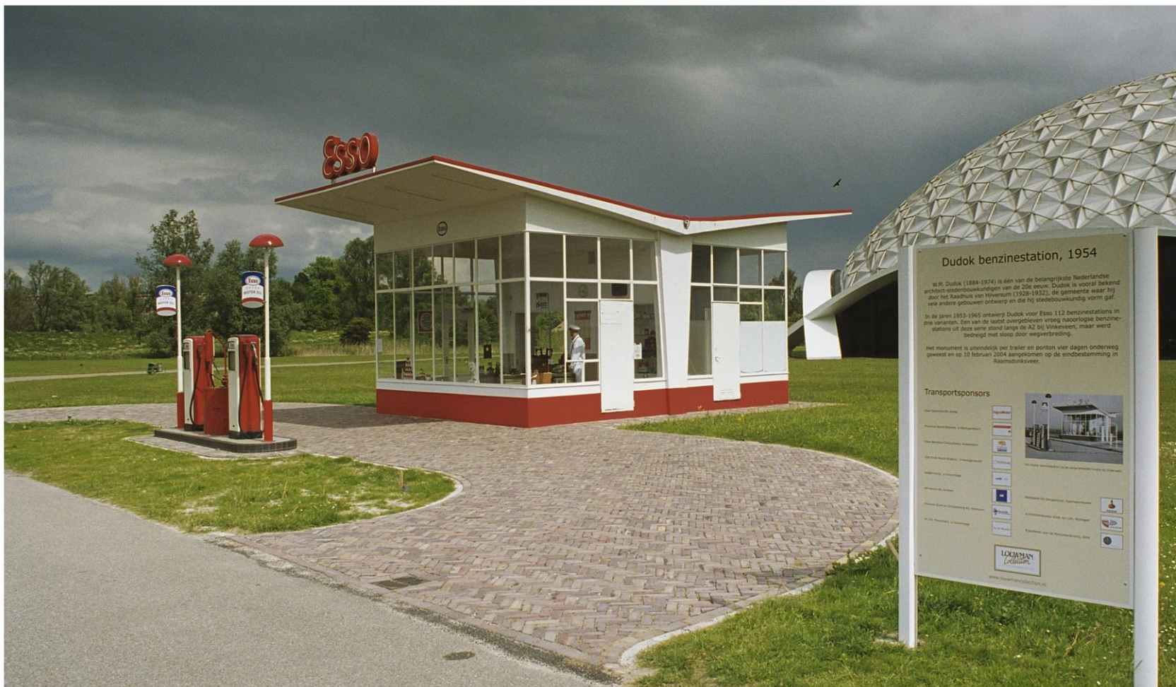
Dudok benzinestation - lag voorheen aan Snelweg 2 te Vinkeveen, na restauratie, nu in Raamsdonksveer Bron: Rijksdienst voor Cultureel Erfgoed Amstervoort - documentnr. 521.689
