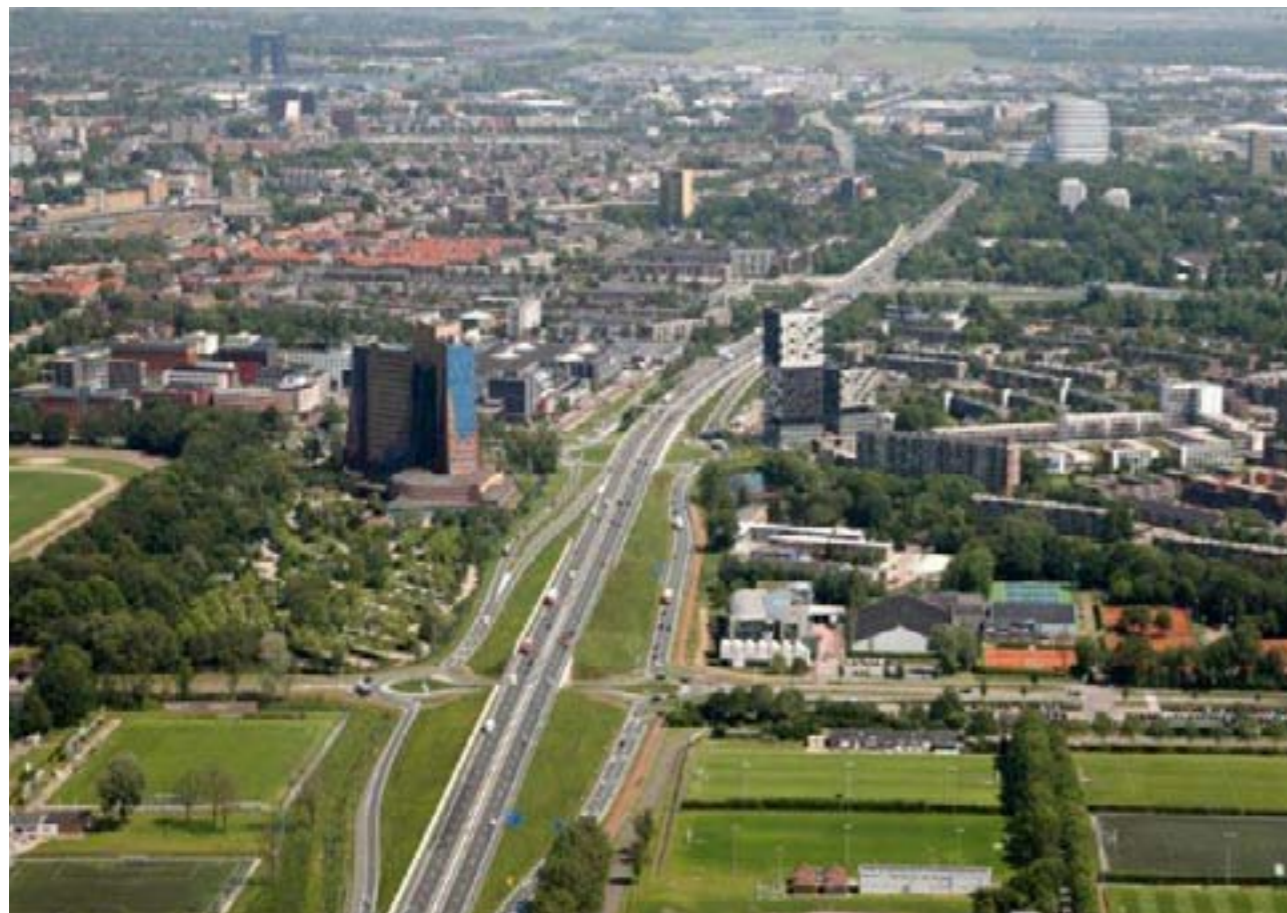
Luchtfoto bestaande situatie A7 bij Vrijheidsplein; bron: Aerophoto Eelde
