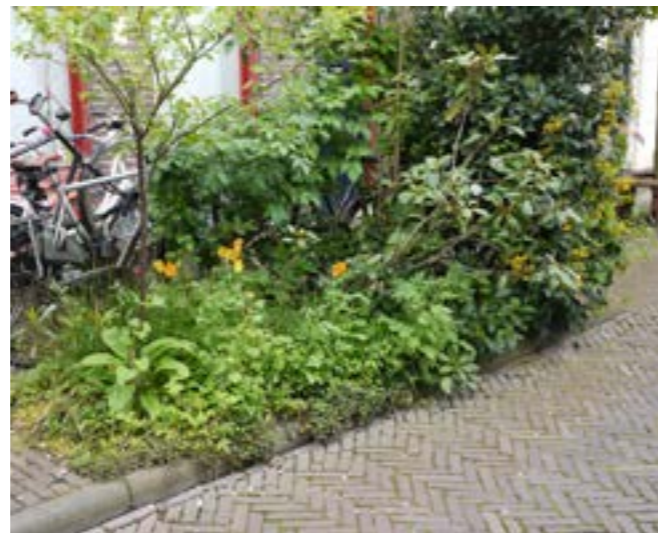
Standaardmateriaal bestrating: bijvoorbeeld klinkers
