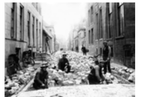
Historische bestrating: behoud of hergebruik
