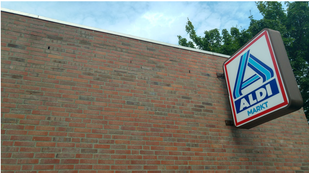
Figuur 3-1 Open stootvoegen
