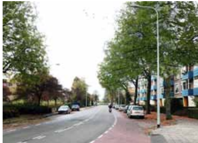
Foto bestaande situatie t.h.v. Werumeus Buningstraat
