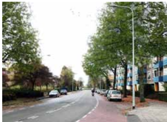
Foto bestaande situatie t.h.v. Werumeus Buningstraat
