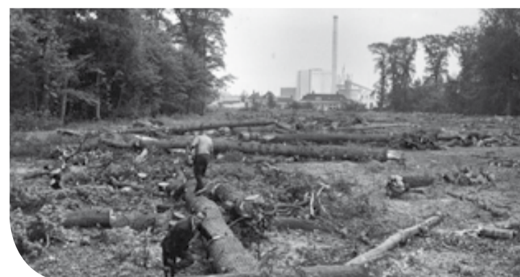
Aanleg zuidelijke ringweg in de jaren '60. Kap van bomen Sterrebos voor de aanleg van de zuidelijke ringweg, 1964. (Foto Folkers, collectie RHC Groninger Archieven; 1785-2269)
