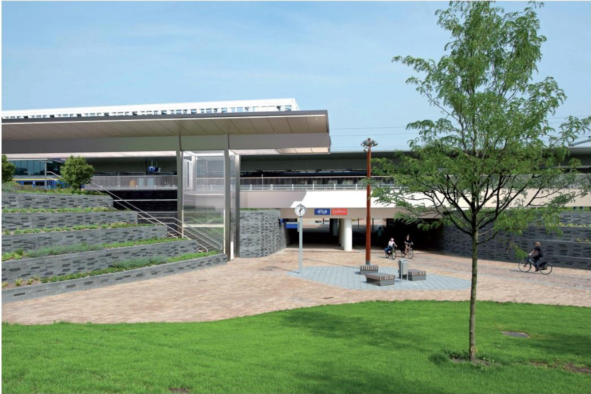
Station met nieuwe perronkap en lift – Helperzoomzijde
