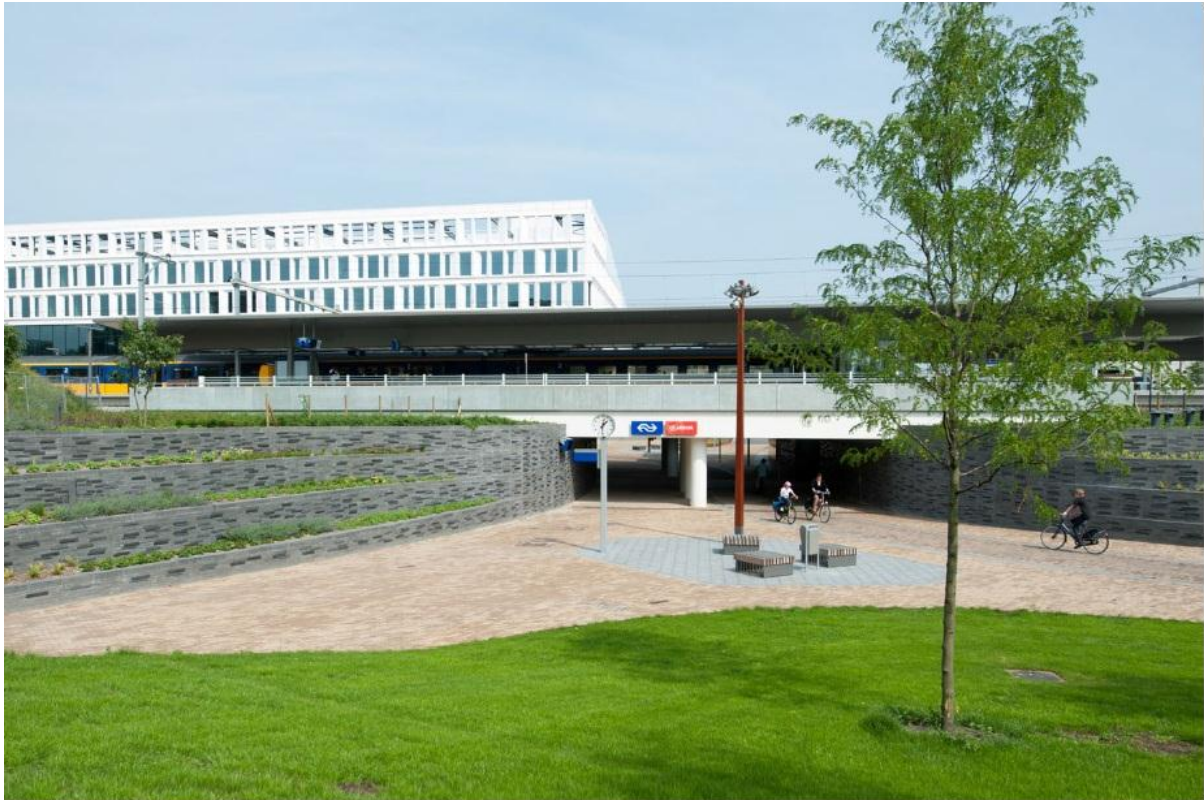
Bestaande situatie – Helperzoomzijde
