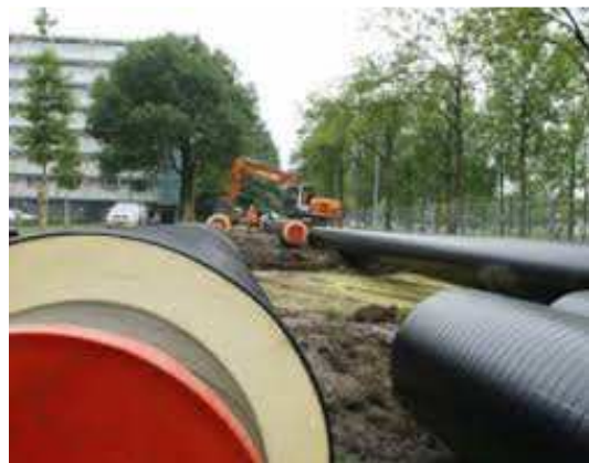
Figuur 6 Stalen buis met isolatie en isolatie mantel
