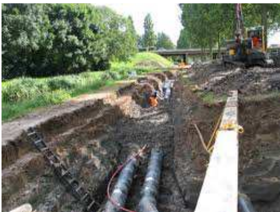
Figuur 5 het leggen van distributieleidingen
