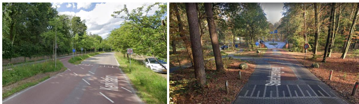
Figuur 4: Praktijkvoorbeelden overgang naar vrijliggend fietspad (links Haren en rechts Vierhouten)
