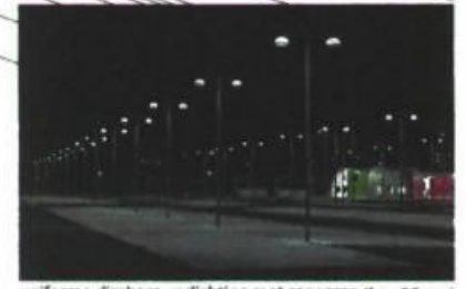
uniforme dimbare verlichting met sensoren (foto: P+Ruter)
