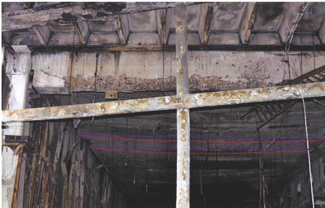
Vloerplaten buigen door. Trekspanning van de voorgespannen wapening is door hitte verwaarloosbaar.
