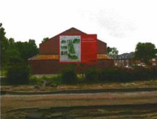
Bessemoerpark in uitvoering
