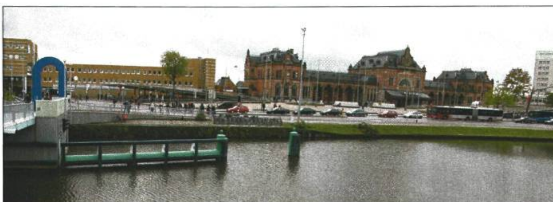
Figuur 3: uitbreiding stallingscapaciteit aan de westzijde van de Werkmanbrug
