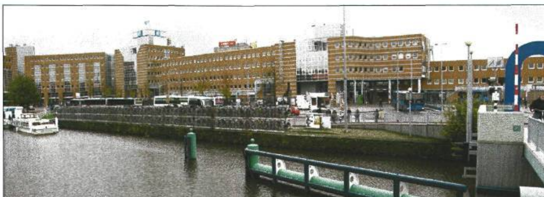
Figuur 1: uitbreiding stallingscapaciteit aan de oostzijde van de Werkmanbrug (vanaf de Werkmanbrug)
