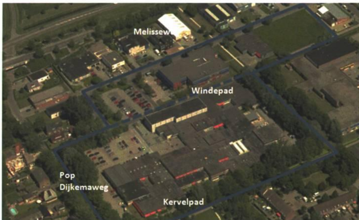
Luchtfoto van het plangebied (bron: Bing maps)
