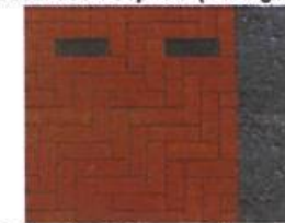
4 Rode straatstenen op rijbaan en trottoir
