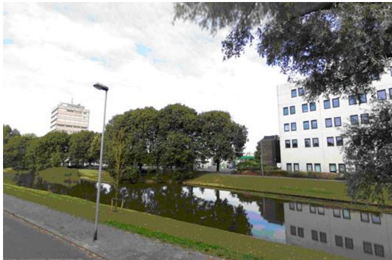
Zuidkant plangebied gezien met rechts het voormalig UWV-GAKgebouw
