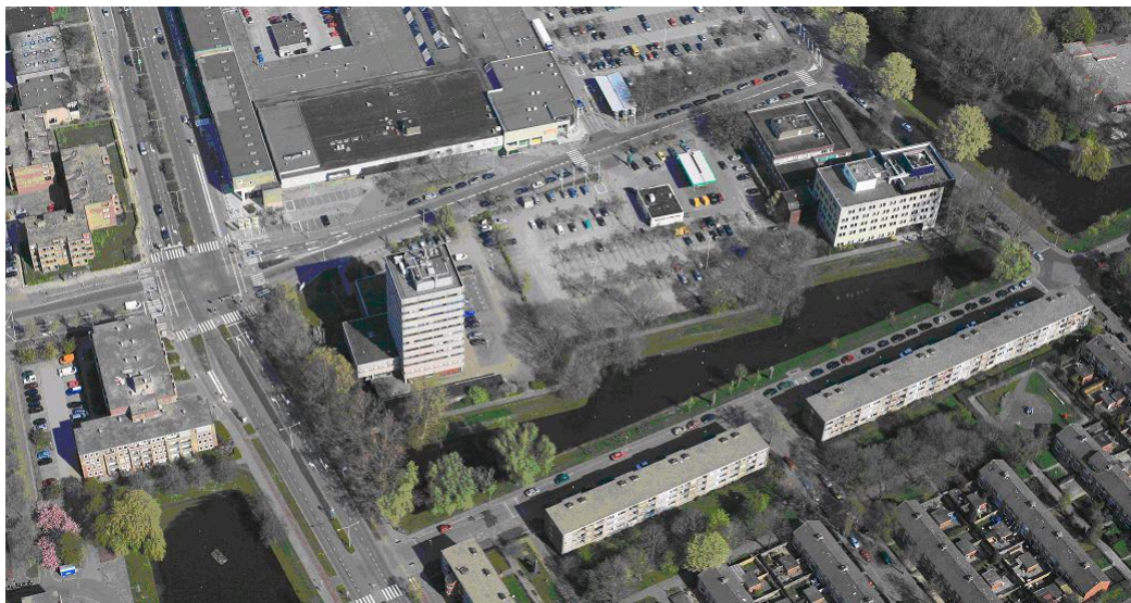
Stadsdeelcentrum Paddepoel, gezien vanuit het zuiden naar het noorden (circa 1971)
