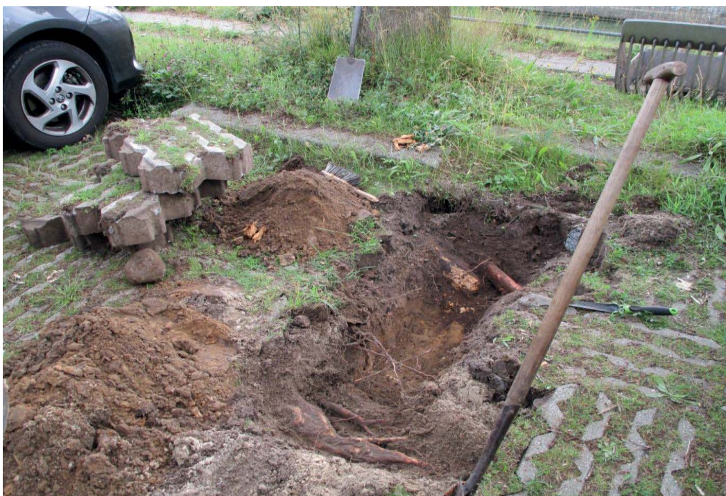
Beeld van de beworteling in proefsleuf
