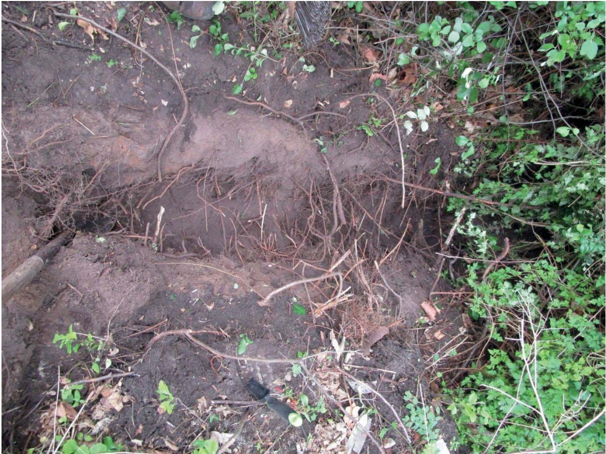
Beeld van de beworteling in proefsleuf
