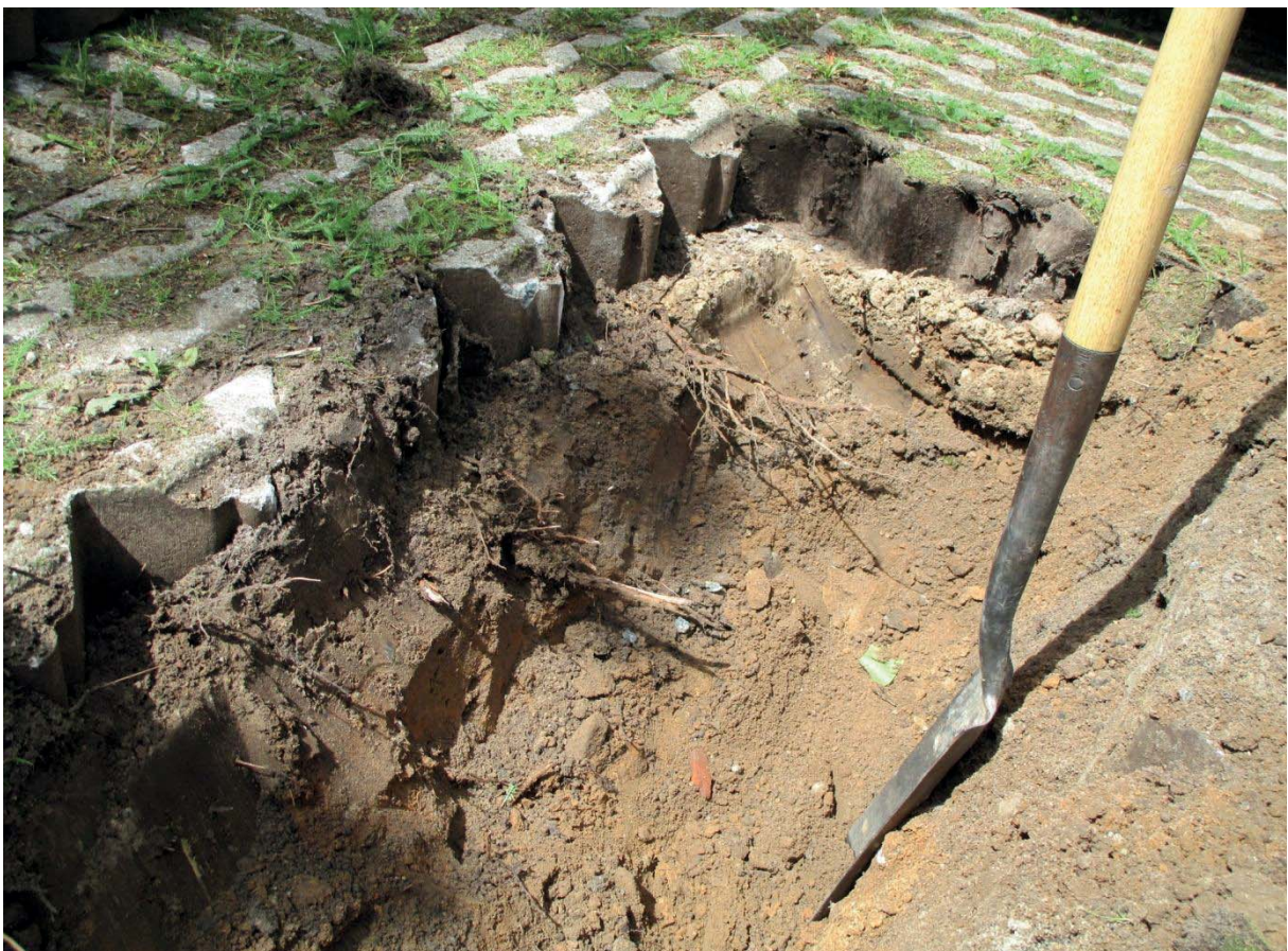
Beeld van de beworteling in proefsleuf
