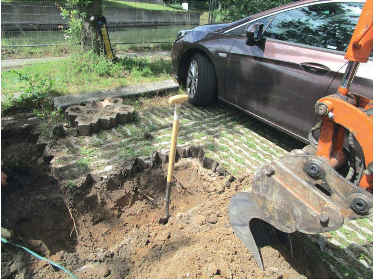
Beeld van de beworteling in proefsleuf
