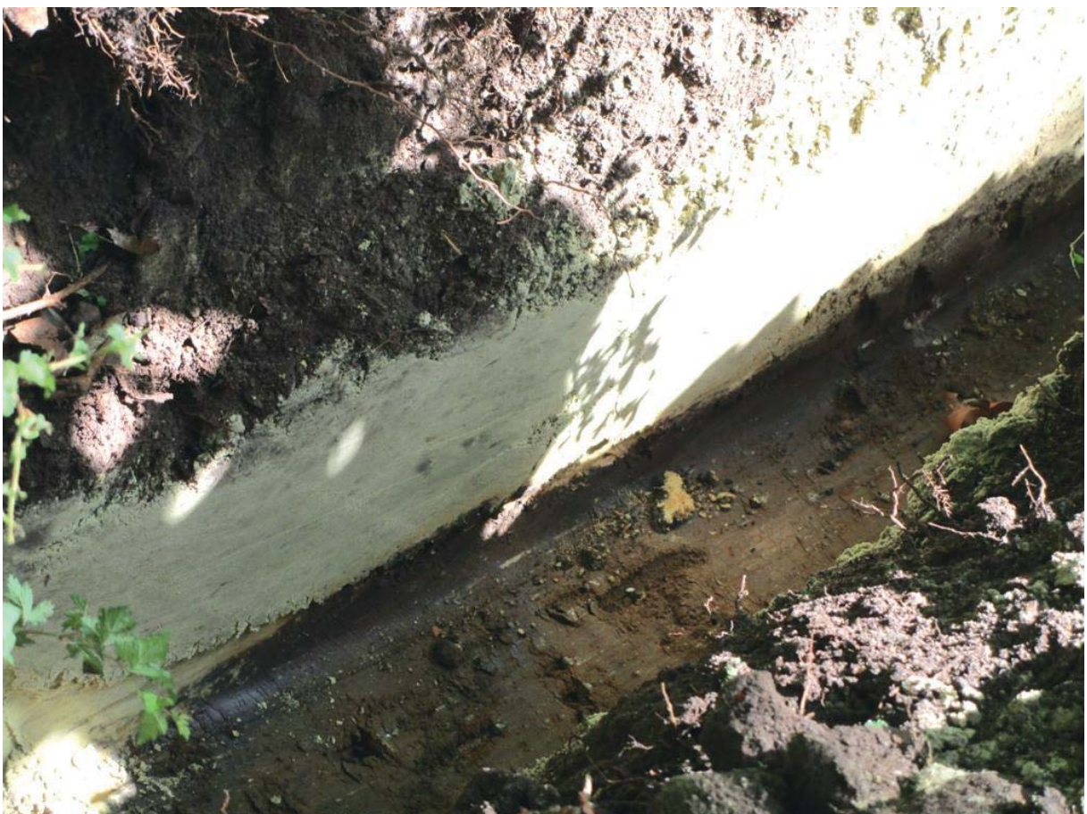
Beeld van (de beworteling in) proefsleuf
