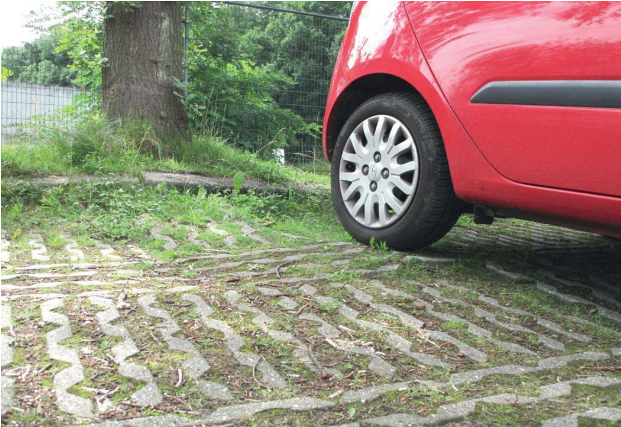
Foto 1: voorbeeld van opgedrukte trottoirbanden en graskeien als gevolg van oppervlakkige wortelgroei
