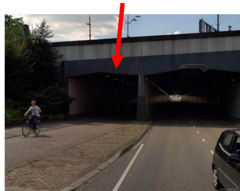
Fiets tunnel bij tunnelweg 27 brommers, geen auto's
