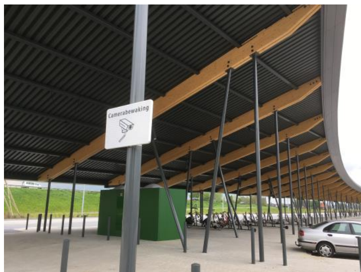
De overkapping van de P+R-voorziening
