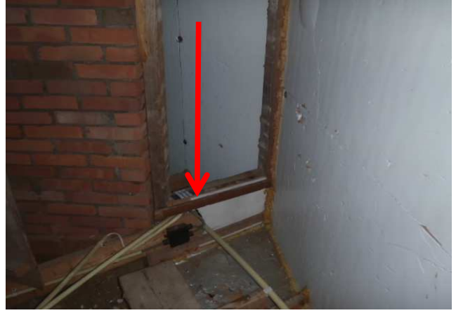
Foto 2 KM 1, voorbij dit kozijn is ong 30m2 betreedbaar
